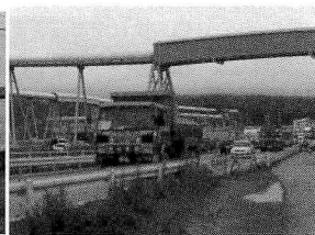
写真 20・21 陸前高田市市街地かさ上げ (高台) 工事 総延長約3kmの巨大コンベヤーで土砂を運搬 まるで宇宙都市のようだ (2014.8/21)
