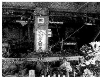
写真4 旧市役所庁舎1階玄関 津波で流されてきた車・机が散乱 (2012.8/24)
