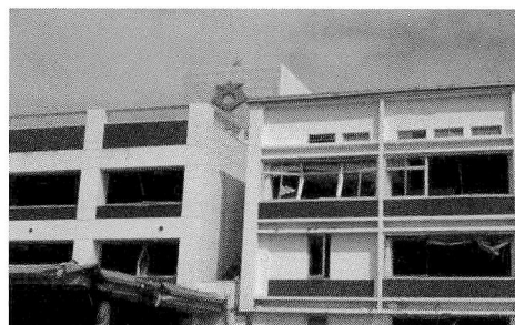
写真3 旧市役所庁舎 津波で全壊 4階建ての3階まで水没(2012.8/24)
